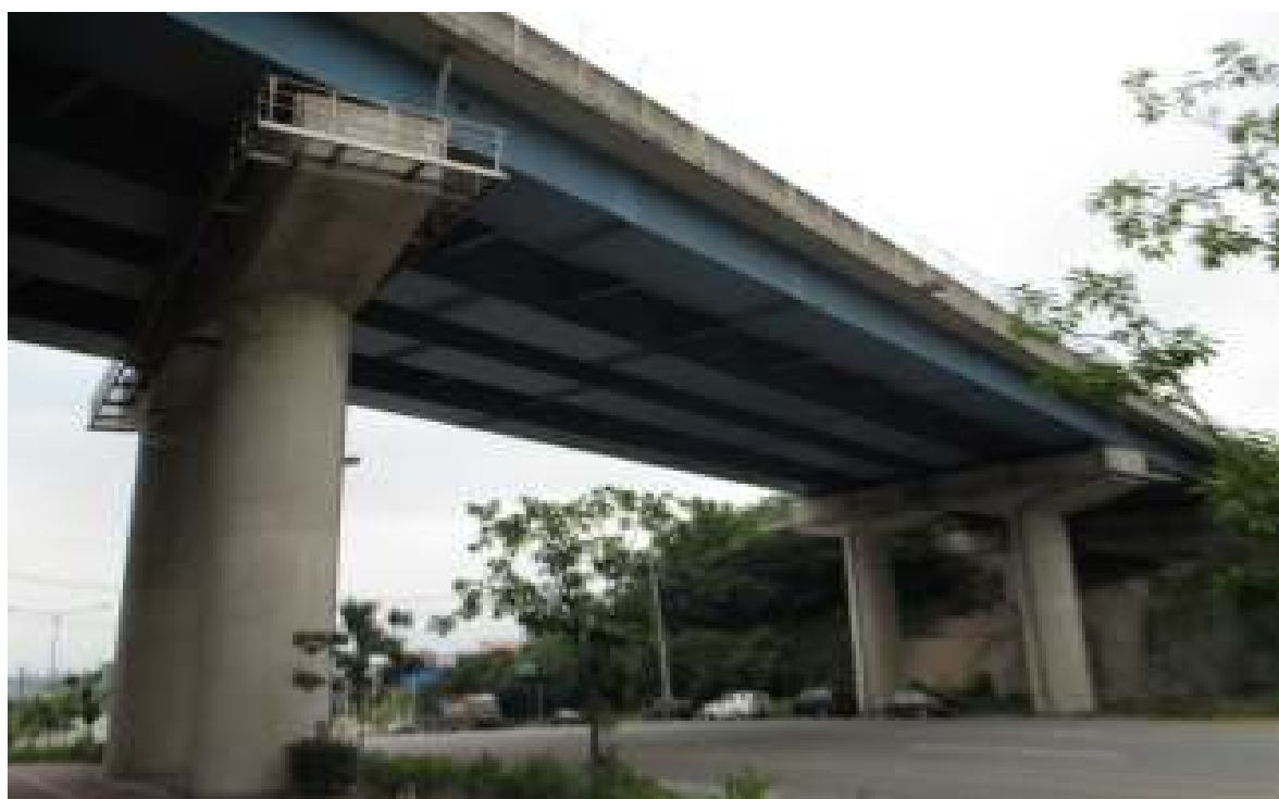
교량 측면 전경
