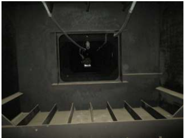
위 치 STEEL BOX 내부 현황 현 황 상태양호
