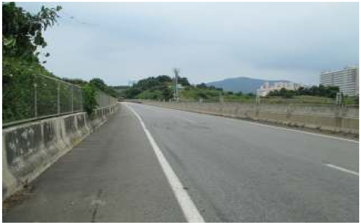
교량 상부 전경
