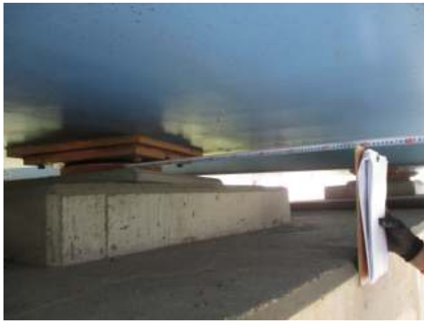
위 치 연단거리측정 현 황 상태양호
