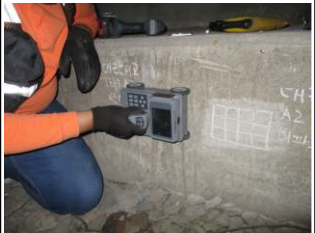
철근 피복두께 측정
