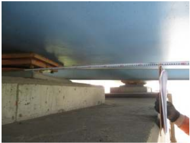
위 치 연단거리측정 현 황 상태양호
